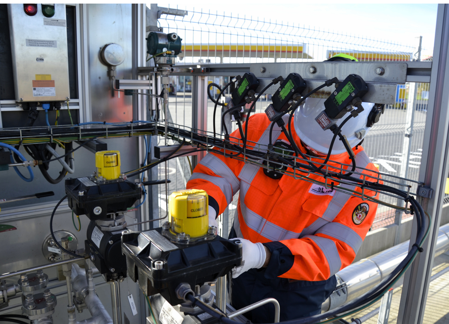
Serwis specjalistyczny przy pracy
